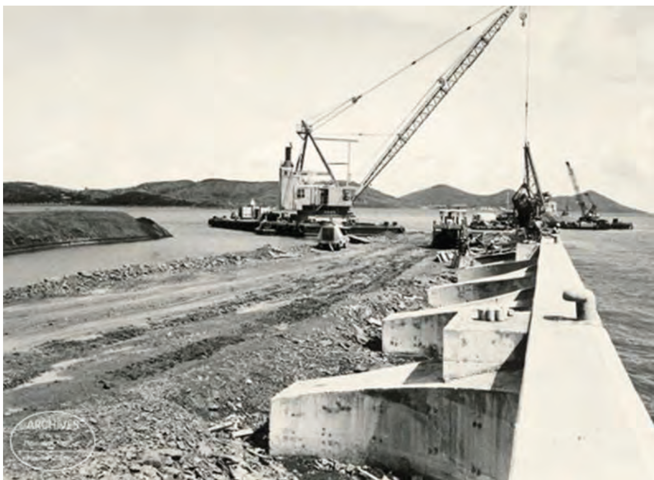
Photographie 6 : Poutre de superstructure du quai de la grande rade en 1971
